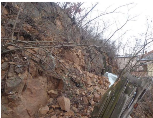
Skalni stěna za domem č. 56 s relativně novým skalním zřícením.
