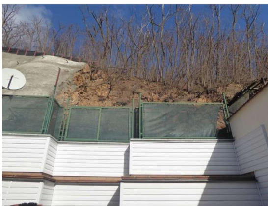
Skalní svah nad opěrnou zdí za domem č. 58. Na skále přítomny náletové dřeviny. Nad horní hranou skály bude umístěn ochranný plot, podobně jako nad již sanovanou skálou vlevo.
