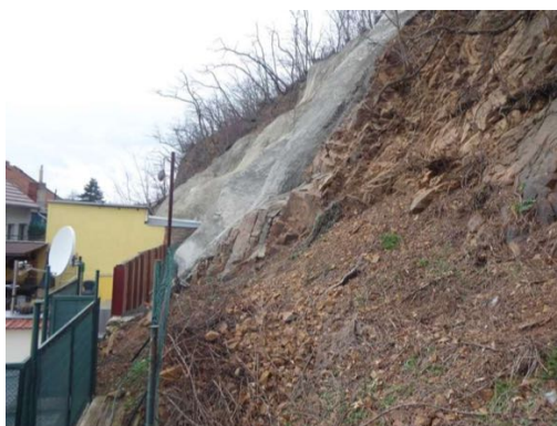
Skalni stěna za domem č. 58 s velkým množstvím opadáných kamenů v akumulační oblasti. Svah za sousedním domem č. 60 již byl sanován stříkaným betonem.
