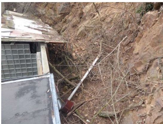
Akumulační prostor pod svahem u domu č. 54 značně zaplněn kameny a ořezanými náletovými dřevinami, který je nutno vyčistit.
